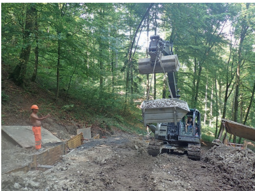
Bei den vier Meter tiefen Grabenarbeiten ist Präzision gefragt.
