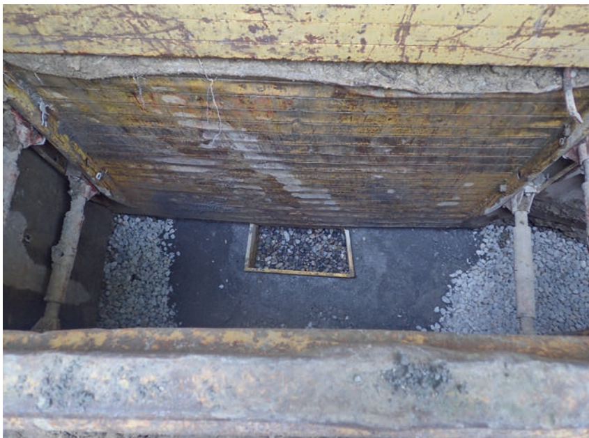
Trotz starker Spriesswände braucht es Mut, in der Grabensohle tief im Boden zu arbeiten.
